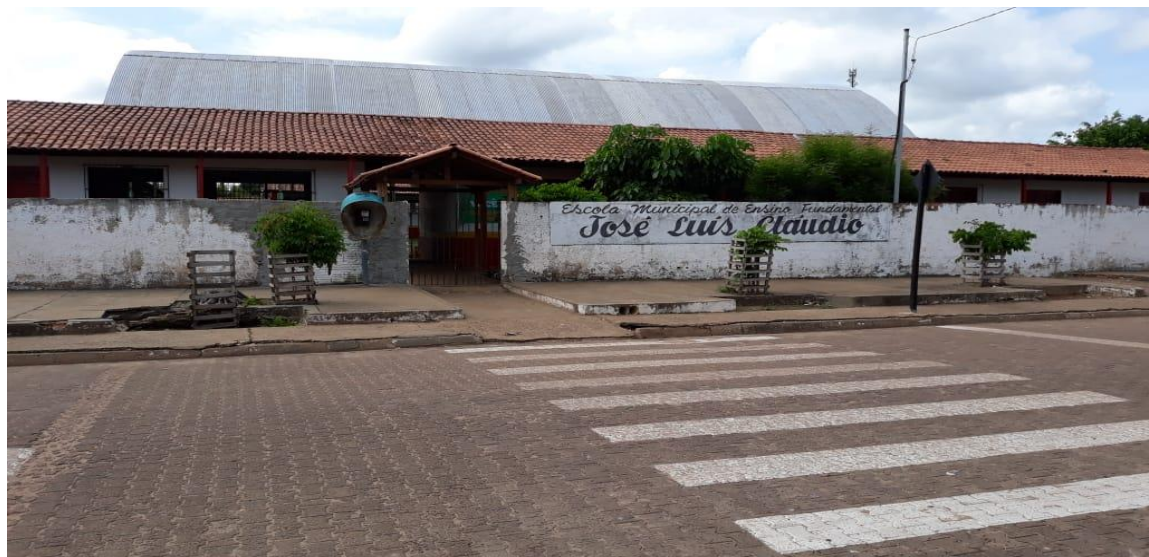
Figura 4: Foto atual da fachada da escola .
