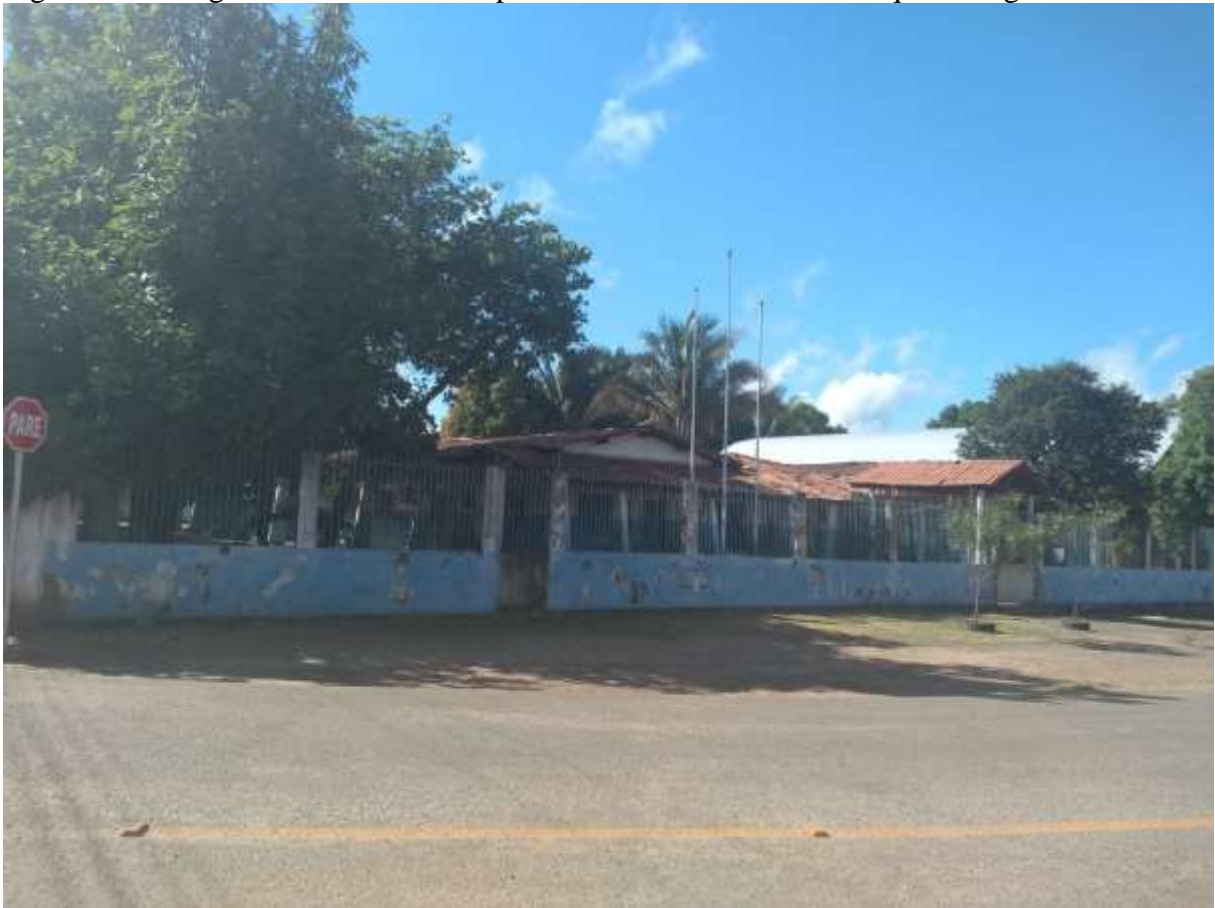
Figura 29 – Imagem da Escola Municipal de Ensino Fundamental Pequeno Pagé
